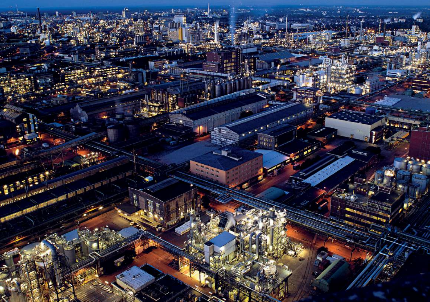
Завод BASF, Людвигсхафен, Германия
